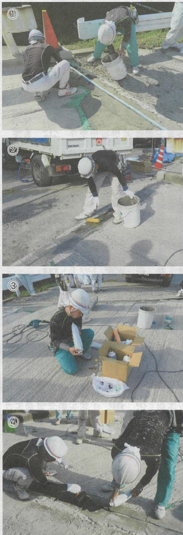
舗装切削後引き渡し、①既設目地材を撤去し、施工箇所の不陸修正を行う②プライマーを塗布する③材料を攪拌する（機材等不要）④材料を遊間に充填する⑤メッシュシートを貼り付ける⑥床版全体にプライマーを塗布する⑦常温塗縮防水材を床版全面に塗布する⑧橋面防水と伸縮装置を一体化させる⑨橋梁上部全面へ材料塗布装置を一括り渡し後、全面舗設へ完了。
