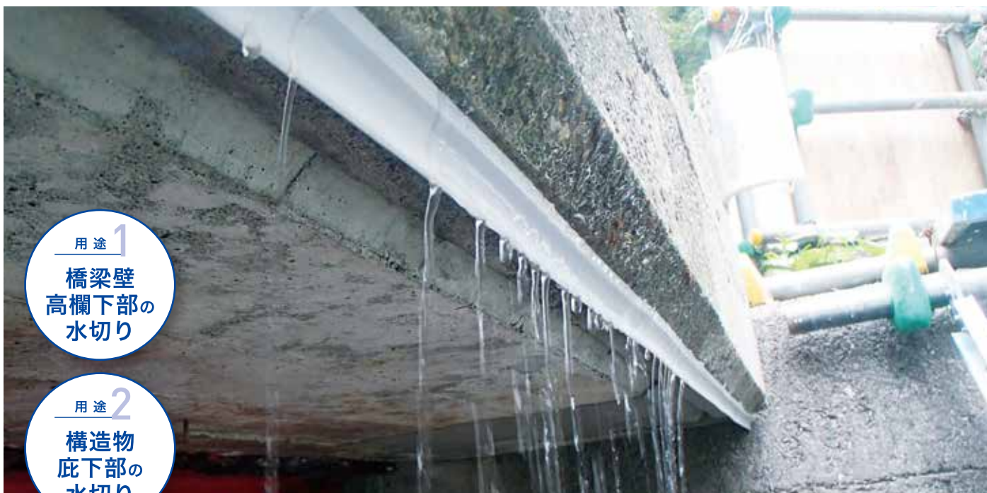
構造物庇にウォーターカッター設置状況
